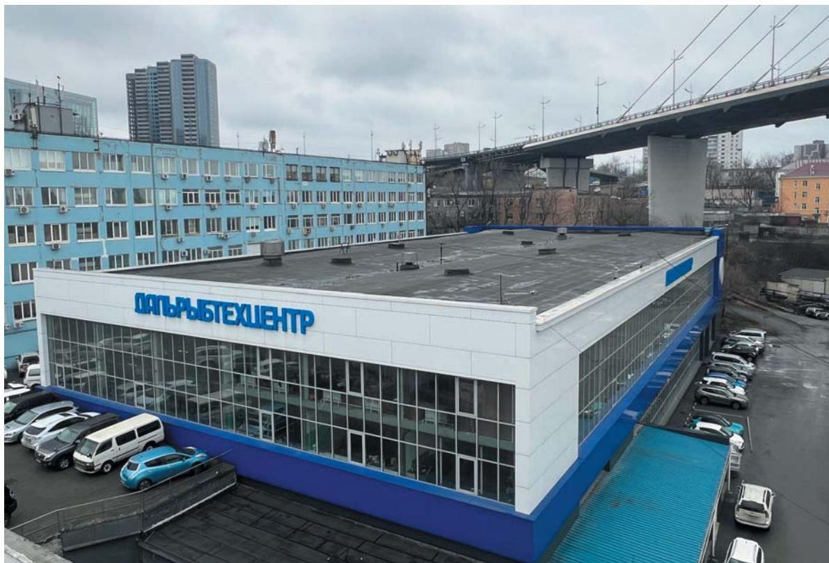
Производственный корпус АО «Дальрыбтехцентр»
