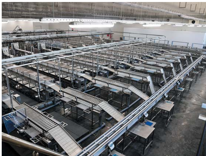
Изготовление и монтаж технологических линий на заводе «Русский минтай»
